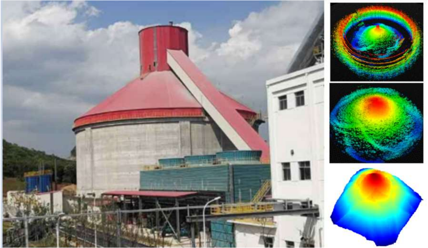
介可视·雷达全景扫描系统测试轮廓(点云)示意图
