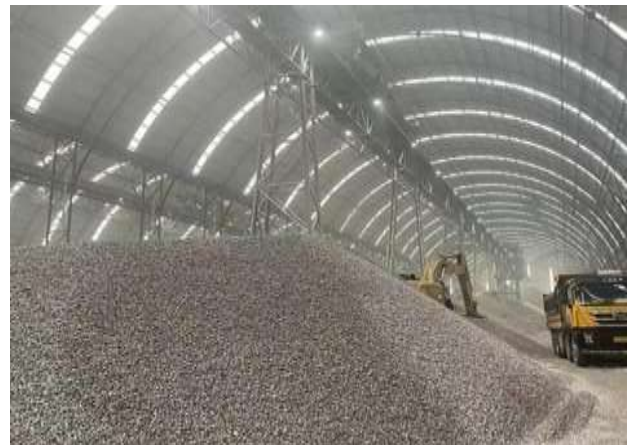
堆场内卡车倾倒，堆土机堆放
