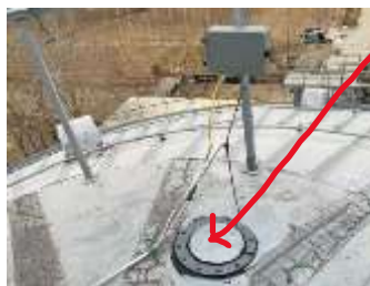
筒仓顶部安装
