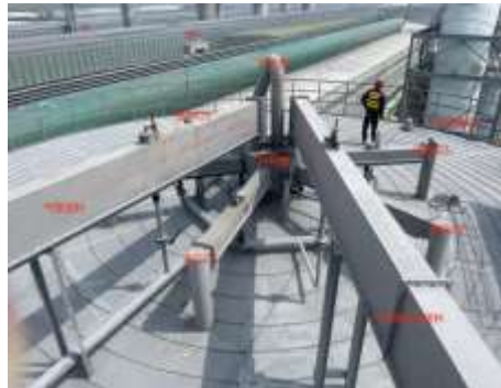
筒仓顶部进料口
