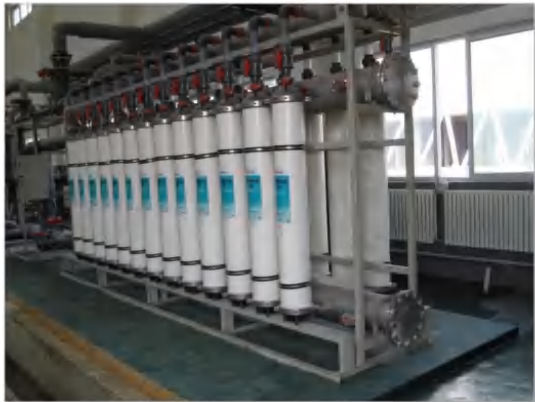
PCB废水回用系统及管路
