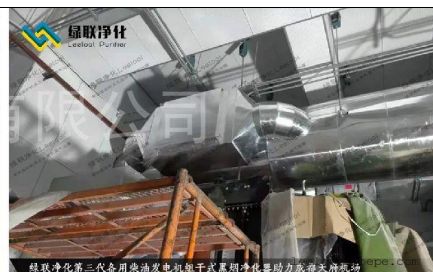
绿联净化第二代备用柴油发电机组干式黑烟净化器助力成都天府机场
