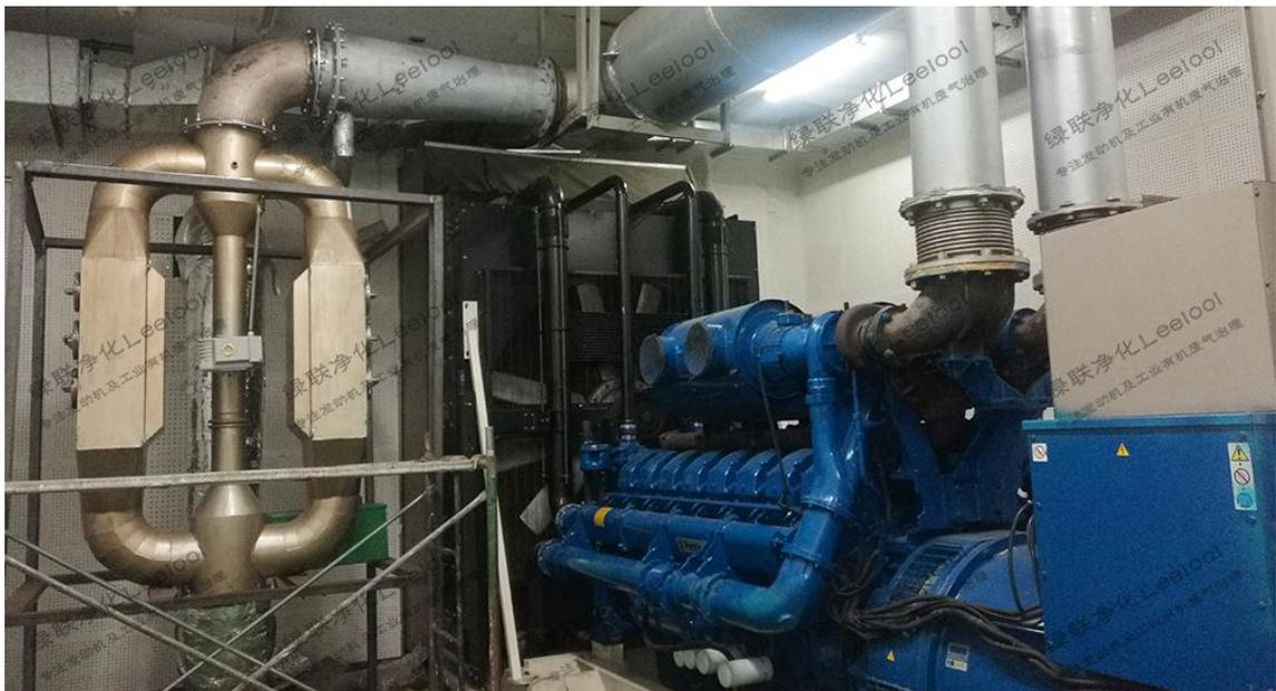
本项目机房现场图片（发动机匹配绿联干式黑烟净化器）
